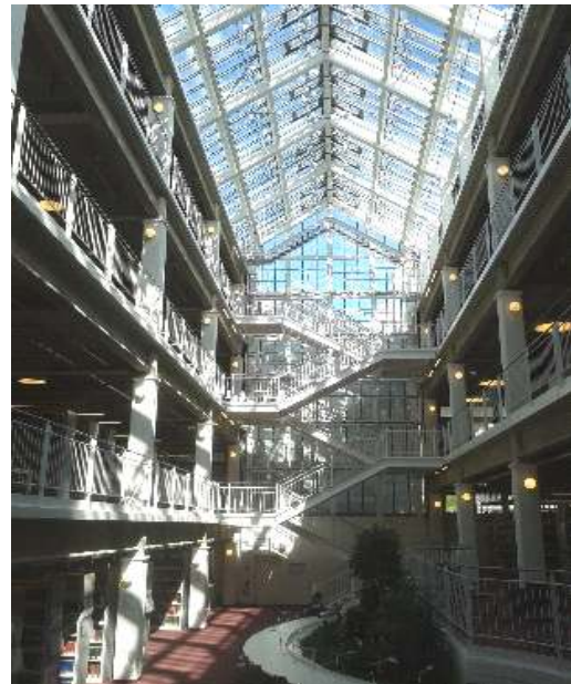
[사진 9] 리모델링된 구 건물
