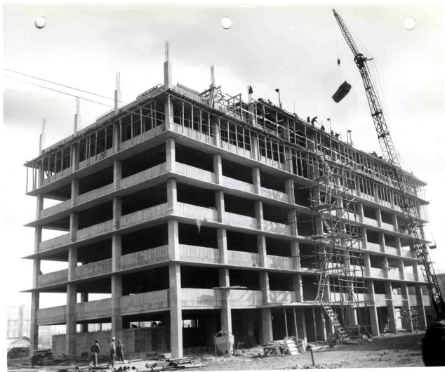
「주한유솜 청사 건설 공사 월간 진행 보고서」에 첨부된 사진 1960년 11월 30일의 공사 현황을 보여준다.
